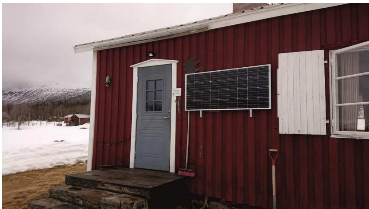
En 160 W solcell på Aktsestugans vägg ger ström till belysning och mobilladdning. Foto: Anders Friström.
